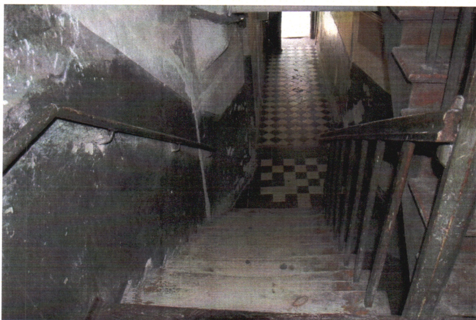
Fot. 48. Klatka schodowa – widok z podestu między parterem a piętrem w kierunku wejścia głównego.
