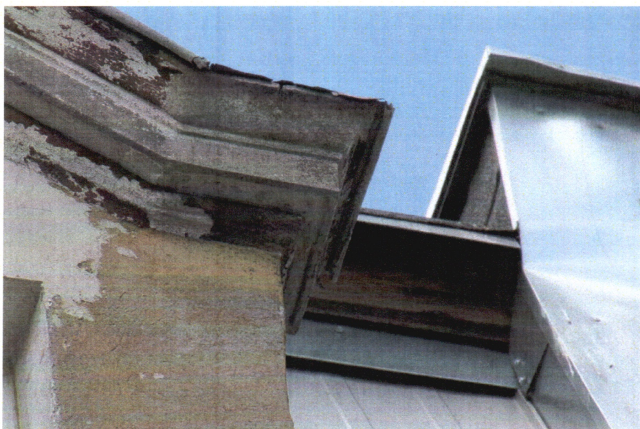
Fot. 8. Elewacja frontowa – opierzenia blacharskie ściany i komina wykonane w czasie ostatniego remontu dachu.
