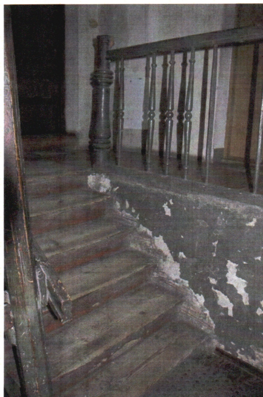
Fot. 41. Klatka schodowa – schody prowadzące na piętro II. Fragmentarycznie zachowana balustrada schodów i barierka podestu.
