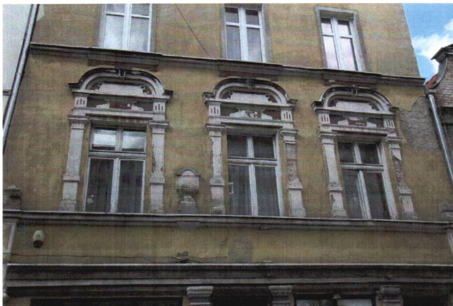
Fot. 3. Elewacja frontowa – I piętro. Oryginalna stolarka okienna na I piętrze.
