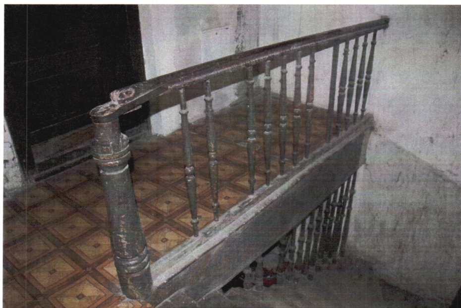
Fot. 42. Klatka schodowa – schody prowadzące na piętro II.
