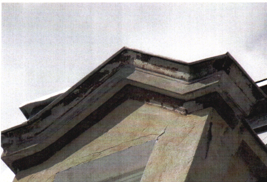
Fot. 10. Elewacja frontowa – gierowane zwieńczenie lukarny.
