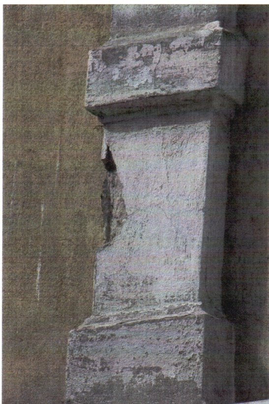
Fot. 13. Elewacja frontowa – detal architektoniczny w postaci stylizowanej steli usytuowany pomiędzy otworami okiennymi I piętra. Widoczne znaczne zniszczenia substancji zabytkowej oraz próby napraw.
