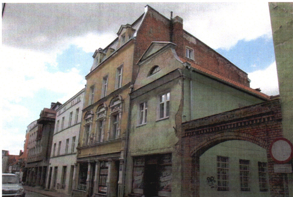
Fot. 25. Widok pierzei ulicznej w kierunku ratusza. Widoczny fragment elewacji bocznej od strony budynku nr 7.
