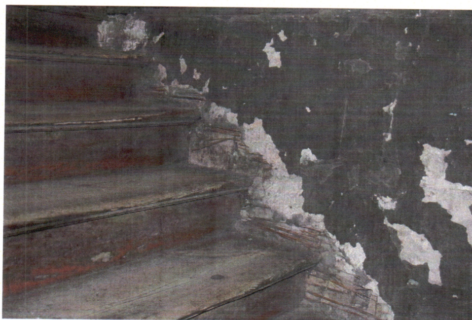
Fot. 50. Struktura ściany wewnętrznej z widocznym deskowaniem pokrytym trzciną i wyprawą tynkarską oraz powłoką malarską..
