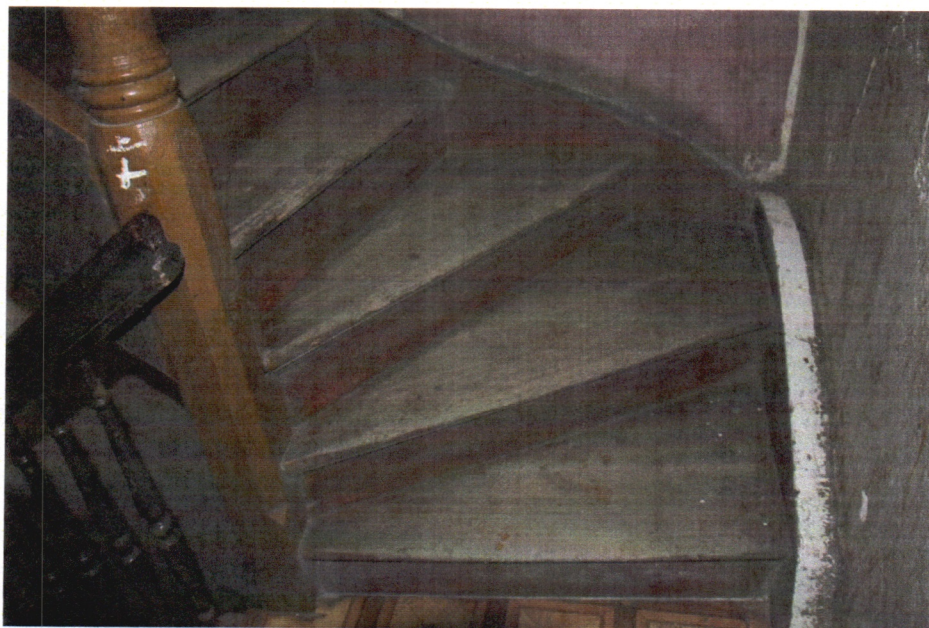
Fot. 49. Schody prowadzące na poddasze – zabieg schodów drewnianych z widocznymi polickami zewnętrznymi i przyściennym.
