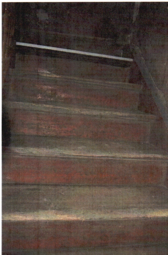
Fot. 39. Klatka schodowa. Drewniane stopnice z widocznym, miejscowo bardzo zniszczonym profilem krawędzi
