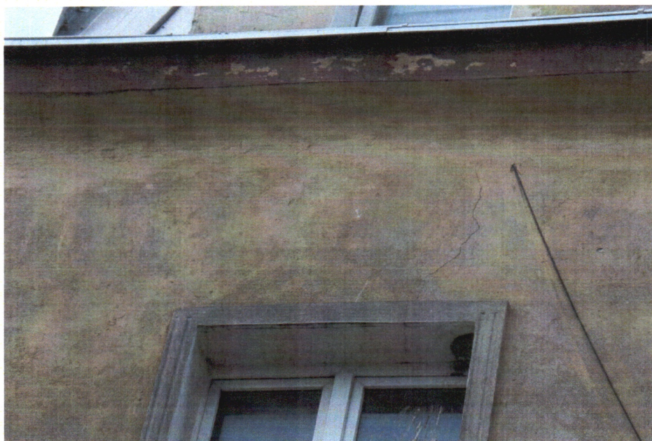
Fot. 5. Elewacja frontowa – gzyms podokapowy. Widoczna wtórna powłoka malarska. Słupki opaski wokół otworu okiennego dekorowane dwoma żłobkami.
