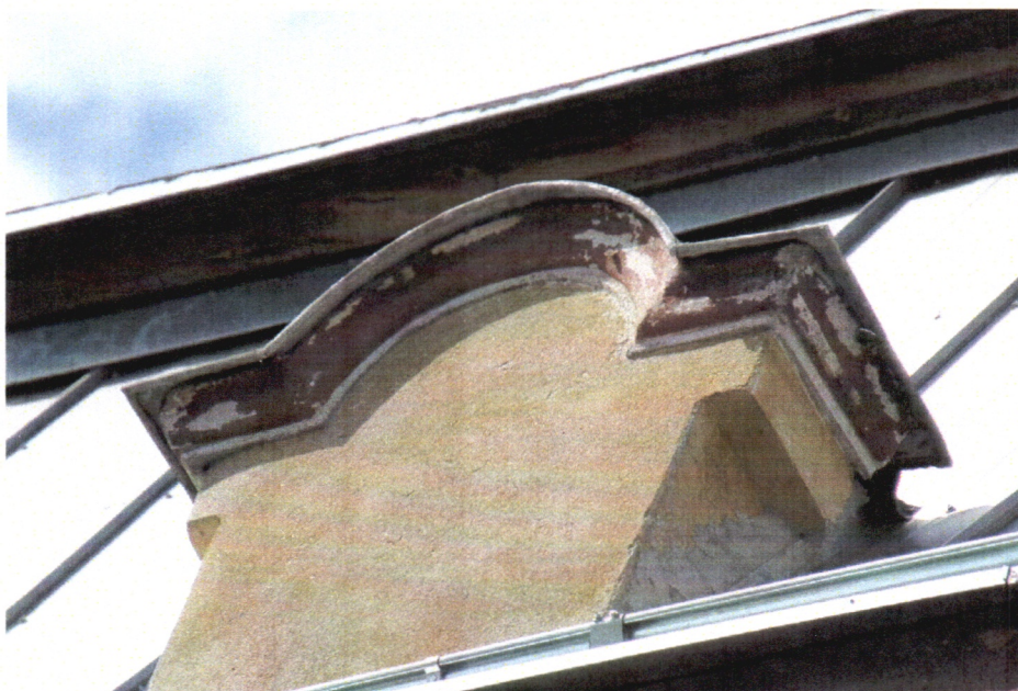
Fot. 9. Elewacja frontowa – współczesne pokrycie połaci dachu wykonane z pasów blachy tytanowo-cynkowej, układanej na rąbek stojący.
