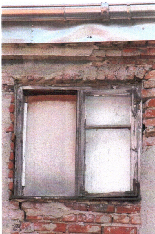
Fot. 31. Elewacja podwórzowa. Kondygnacja poddasza. Widoczny wtórny lub wtórnie rozkuty prostokątny otwór okienny. Znaczne ubytki wypraw tynkarskich oraz zaprawy wiążącej cegły muru. Widoczne spękania muru pod otworem okiennym (brak ławy okiennej oraz właściwie wykonanego nadproża).
