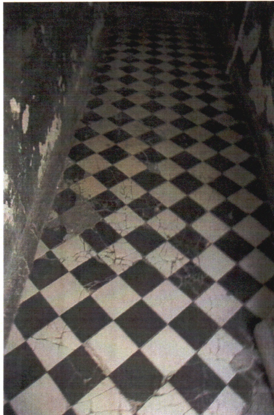
Fot. 37. Korytarz klatki schodowej w trakcie frontowym. Posadzka układana z płytek w karo; pasowo; naprzemiennie kremowych i czarnych.
