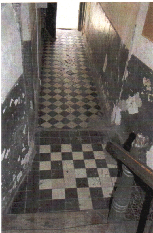
Fot. 35. Widok klatki schodowej w kierunku wejścia głównego. Korytarz wyłożony czarną i kremową płytką ceramiczną. Płytki w ciągu korytarza układane w karo. Spocznika z czarną bordiurą, zaś wewnątrz w szachownicę
