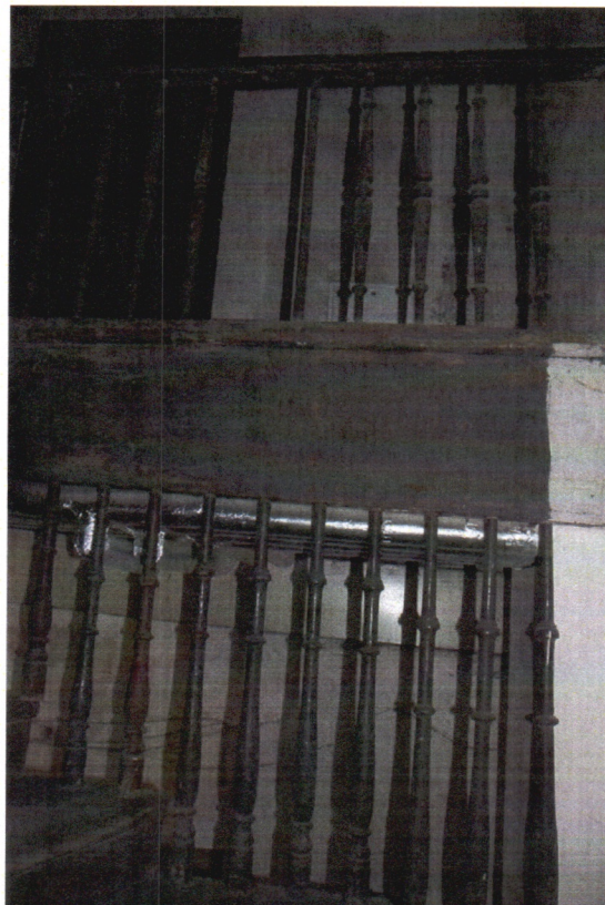
Fot. 46. Balustrady podestu i schodów łączących II piętro z poddaszem.
