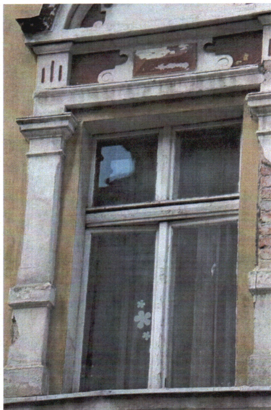
Fot. 11. Elewacja frontowa – oryginalne okno drewniane w poziomie I piętra.
