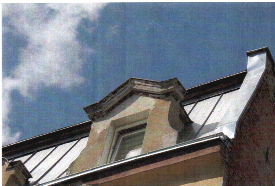
Fot. 7. Elewacja frontowa – lukarna w połaci dachu.
