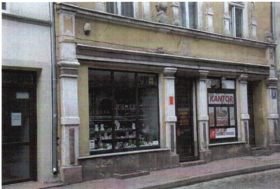
Fot. 19. Elewacja frontowa – przyziemie.
