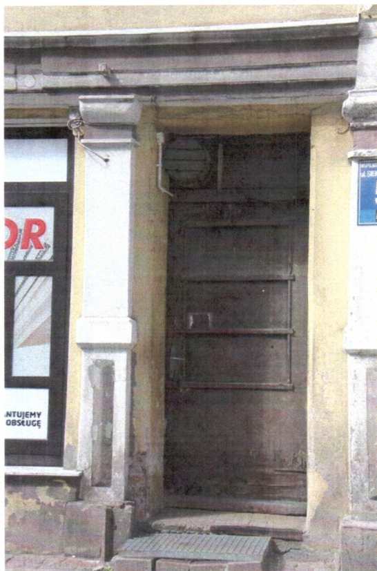
Fot. 21. Elewacja frontowa – drzwi wejścia głównego utrzymane w stylistyce modernizmu; prawdopodobnie zamontowane w miejsce nieistniejących drzwi oryginalnych.
