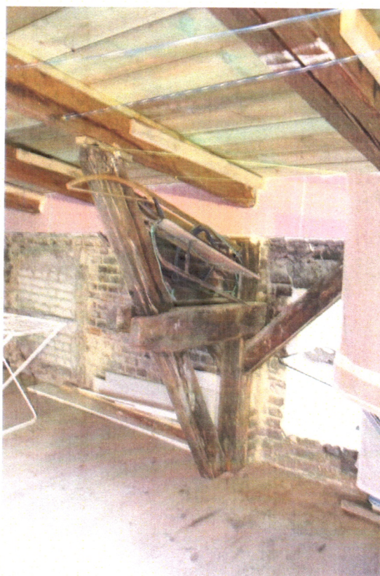
Fot. 54. Poddasze nieużytkowe – widoczny stary element kleszczowej konstrukcji więźby dachowej wspierające nowe belkowanie połaci dachowej wraz z deskowaniem.
