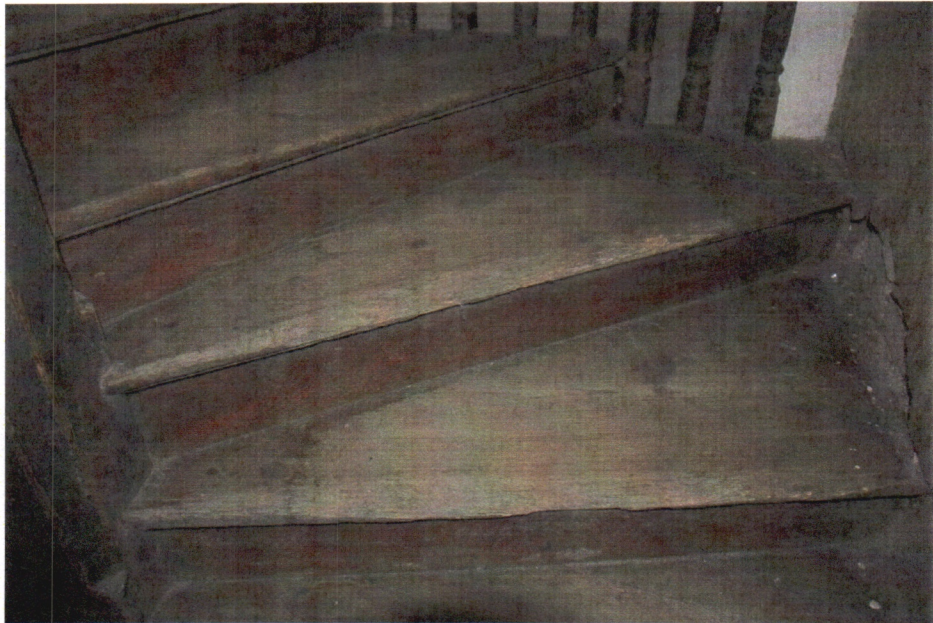
Fot. 45. Drewniany bieg schodów z zabiegiem prowadzący z I na II piętra.
