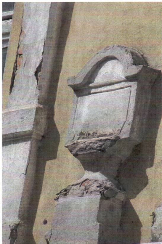
Fot. 13. Elewacja frontowa – detal architektoniczny w postaci stylizowanej steli usytuowany pomiędzy otworami okiennymi I piętra. Widoczne znaczne zniszczenia substancji zabytkowej oraz próby napraw.
