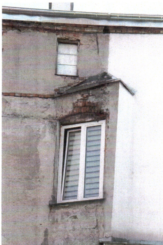
Fot. 31. Elewacja podwórzowa. Kondygnacja poddasza. Widoczny wtórny lub wtórnie rozkuty prostokątny otwór okienny. Znaczne ubytki wypraw tynkarskich oraz zaprawy wiążącej cegły muru. Widoczne spękania muru pod otworem okiennym (brak ławy okiennej oraz właściwie wykonanego nadproża).
