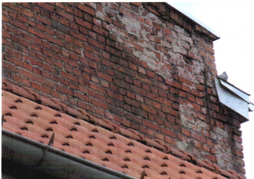
Fot. 27. Elewacja boczna – fragment.
