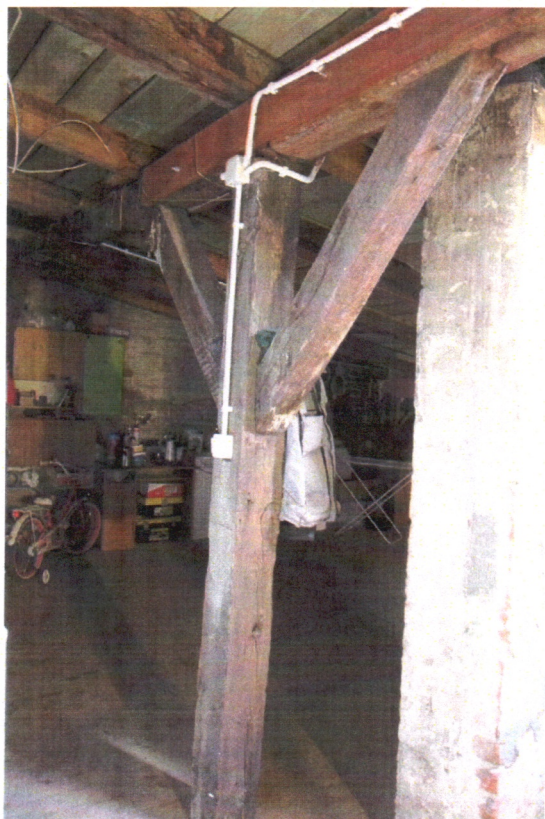
Fot. 53. Poddasze nieużytkowe – więzar więźby dachowej.
