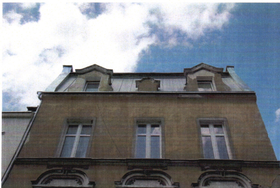
Fot. 4. Elewacja frontowa – II piętro i poddasze użytkowe. Widoczna wtórna stolarka okienna z PCV.
