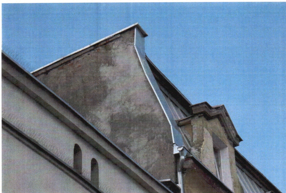
Fot. 23. Fragment elewacji bocznej od strony budynku nr 3.
