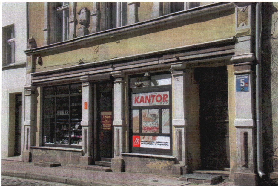
Fot. 2. Elewacja frontowa – przyziemie.
